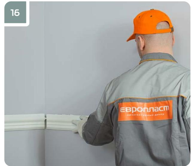
Прижать изделие к стене, чтобы клей выступил из-под всей плоскости примыкания. Смешая изделие вдоль стены, прижать к соседнему изделию, чтобы клей выступил на стыке.
