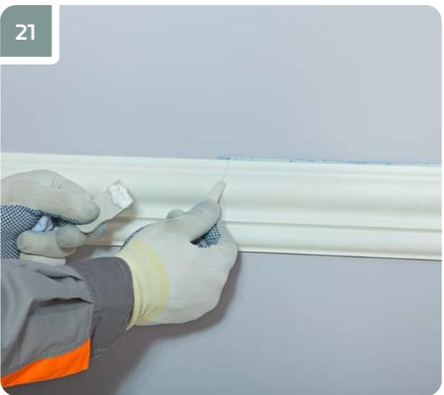
Финишной шпаклевкой для внутренних работ зашпаклевать обработанные стыки, при необходимости повторить «Шаг 20» до получения ровной поверхности.
