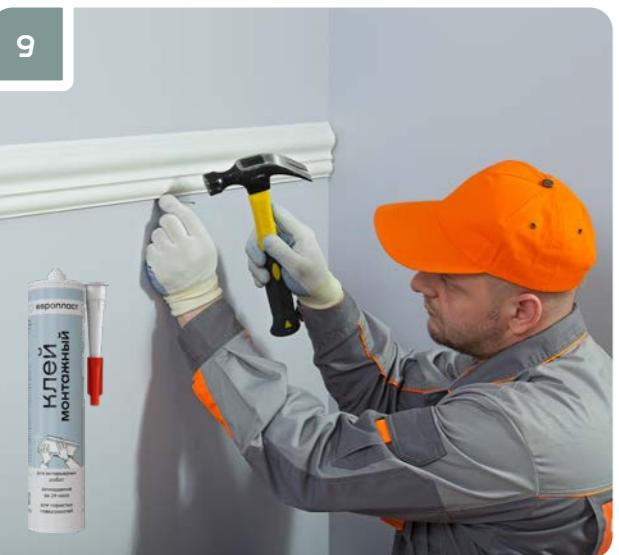
При использовании клея «Европласт Монтажный» для предотвращения сползания изделия необходимо зафиксировать изделие финишными гвоздями, которые вбиваются под изделия. Гвозди удаляются спустя 24 часа.
