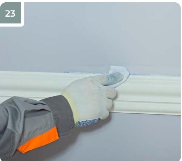
Удалить излишки клея ветошью, смоченной водой – при использовании клея «Европласт Монтажный»; ацетоном – при использовании клея «Европласт Универсальный».
