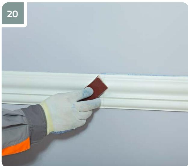
Обработать стыки мелкозернистой наждачной бумагой спустя 4 часа, если при монтаже изделий к стене использовался клей «Европласт Универсальный». Обработать стыки спустя 12 часов, если при монтаже изделий использовался клей «Европласт Монтажный».
