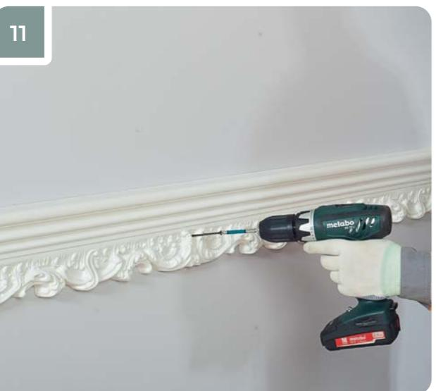
Для молдингов шириной более 100 мм необходима дополнительная фиксация саморезами с шагом ≈ 600 мм.
