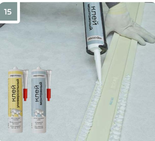
Нанести клей «Европласт Монтажный» или «Европласт Универсальный» на монтажную поверхность следующего изделия.
